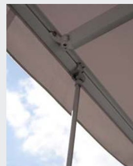
Teleskopstag Stabiliserar markisen vid vind.
